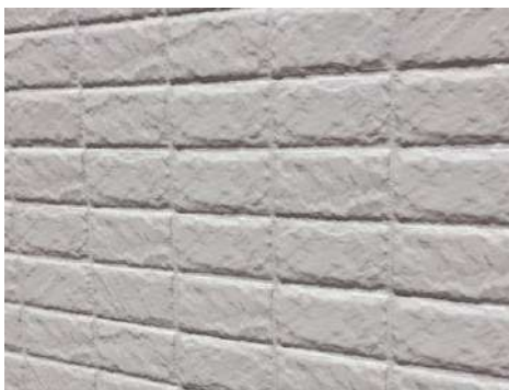
目地部分施工の良い例
